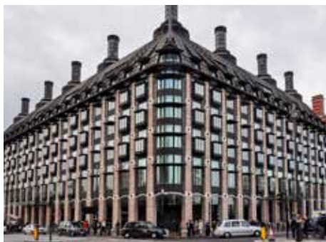
Casa Portcullis en Londres, Reino Unido. Se pueden observar las características chimeneas que forman parte del sistema de auto control de temperatura.
