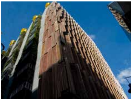
Edificio CH 2 en Melbourne, Australia. En la parte superior se pueden observar las chimeneas de color amarillo. Jonathan Lin. Flickr.
